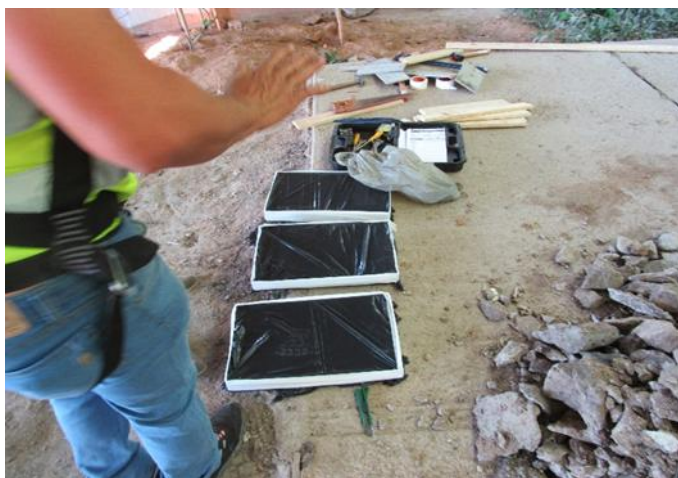
Fotos 163 e 164: Substituição dos aparelhos de apoio do vão gerber. Fonte: Ecosul.
