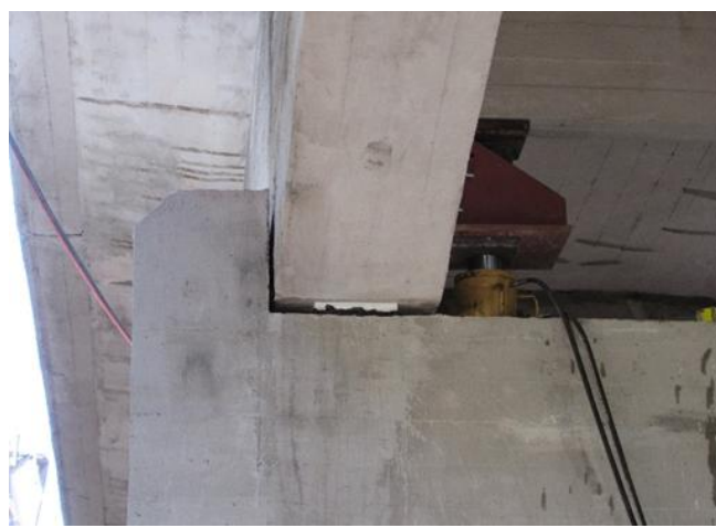
Fotos 163 e 164: Substituição dos aparelhos de apoio do vão gerber. Fonte: Ecosul.
