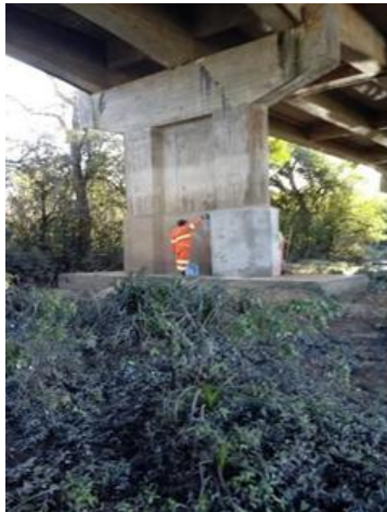
Fotos 161 e 162: Implantação de plataforma suspensa e limpeza da estrutura. Fonte: Ecosul.
