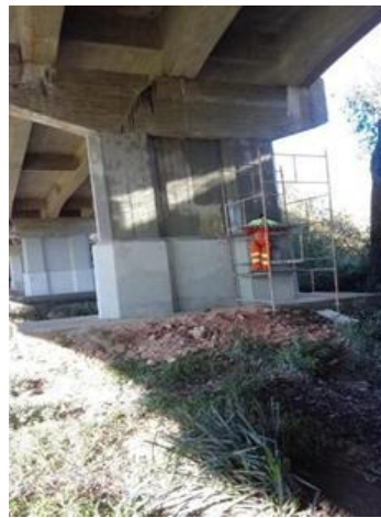
Fotos 161 e 162: Implantação de plataforma suspensa e limpeza da estrutura. Fonte: Ecosul.
